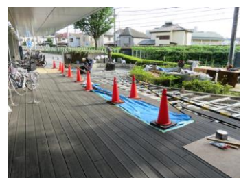
玄関前の床板が新しく
