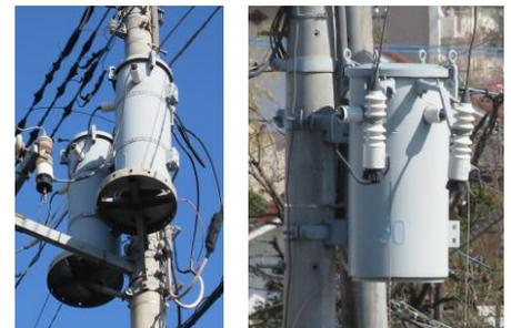
6600Vの電気は、電柱のところどころにある円筒形の柱上変圧器で、100Vや200Vに降圧され、家庭に送り届けられます。地震などで電柱が倒れると、その復旧に多くの時間がかかるのは、うっかり人が触れたら大変なことになる6600Vの電気を、安全に処理するため、多くの手間がかかるからです。
